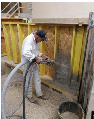
**Chantier démonstrateur de projection de chaux-chanvre dans le bâtiment :**
